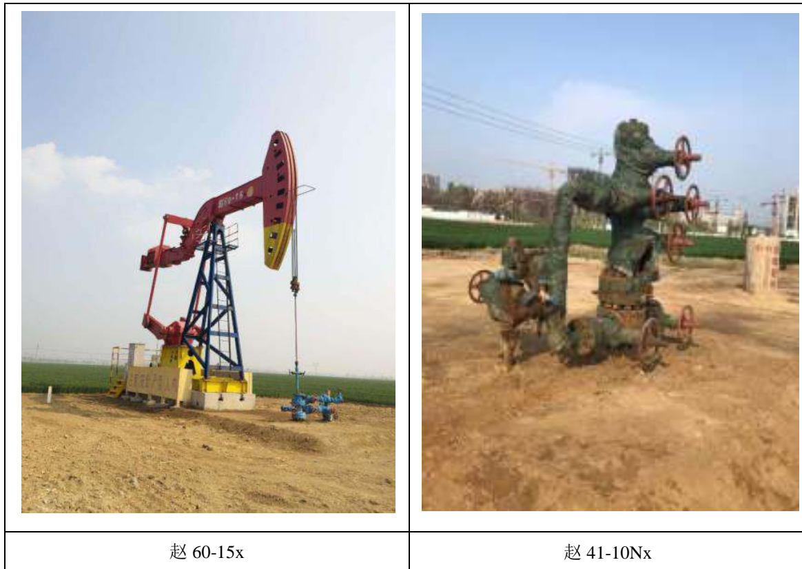
图 3-3 项目油井建设情况
