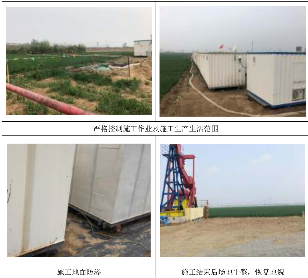
图 5-1 施工期生态保护措施
